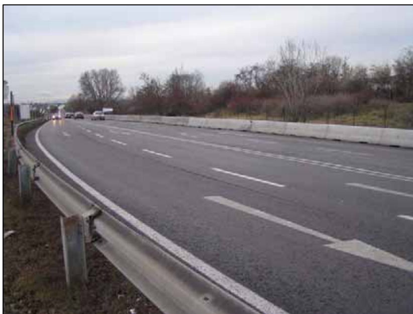
Foto 1: Verflechtungsbereich südlich der Kreuzung mit der L 2087 (Viaduktstraße), Blickrichtung Süden
