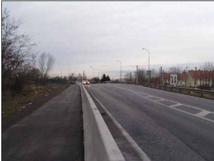
Foto 1: Verflechtungsbereich südlich der Kreuzung mit der L 2087 (Viaduktstraße), Blickrichtung Norden
